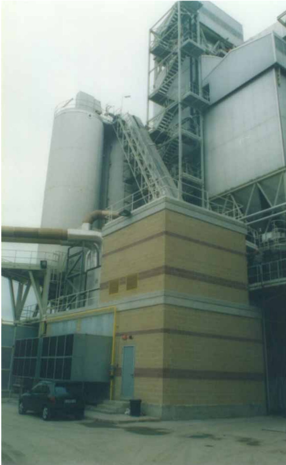
Vista exterior de una planta de cogeneración en una instalación de tratamiento y reciclado de residuos sólidos urbanos. (Barcelona – España)
