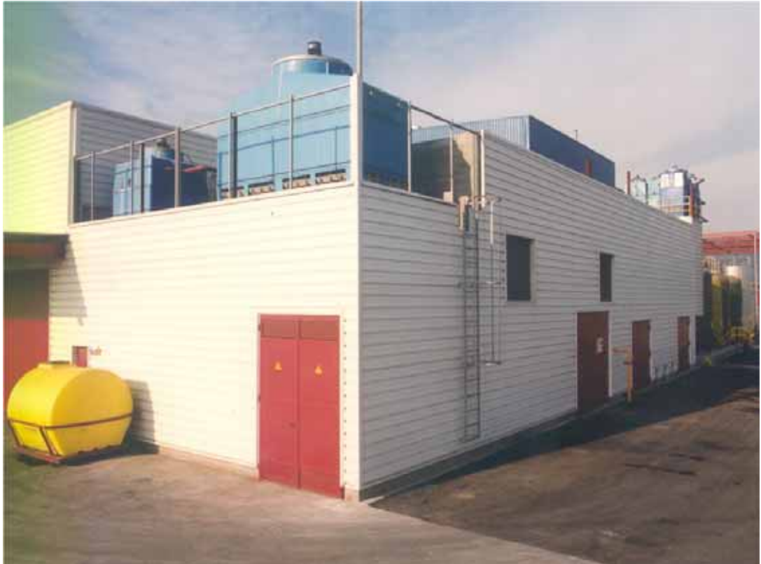
Vista exterior planta de cogeneración y sala de calderas de vapor en Industria Química. (Les Franqueses del Vallés – Barcelona – España)
