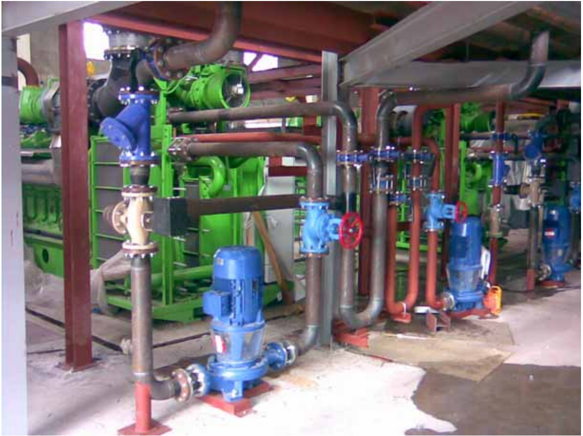
Planta de cogeneración a gas de síntesis de 5922 KW en una fábrica de alcohol. (Campo de Criptana – España)
